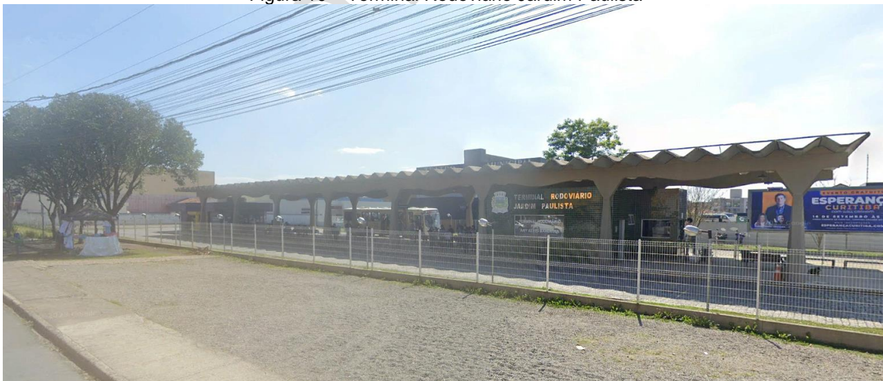
Figura 10 – Terminal Rodoviário Jardim Paulista
