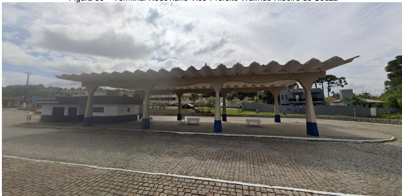
Figura 36 – Terminal Rodoviário Vice-Prefeito Walfrido Ribeiro de Souza
