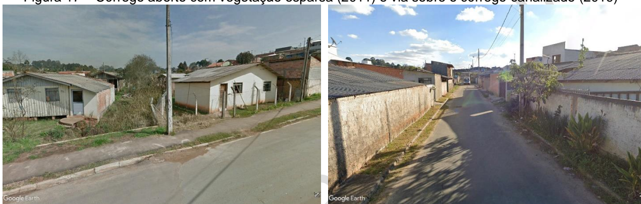
Figura 17 – Córrego aberto com vegetação esparsa (2011) e via sobre o córrego canalizado (2019)
