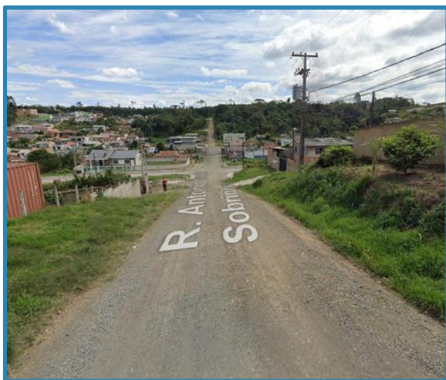
Ausência de calçamento na Rua Antônio Custel Sobrinho
