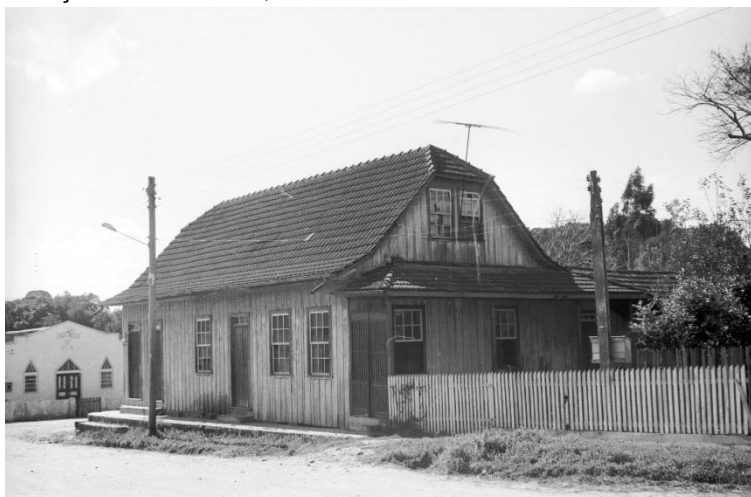
Figura 19 – Edificação urbana mista, construída em madeira no sistema tábua e mata-juntas
